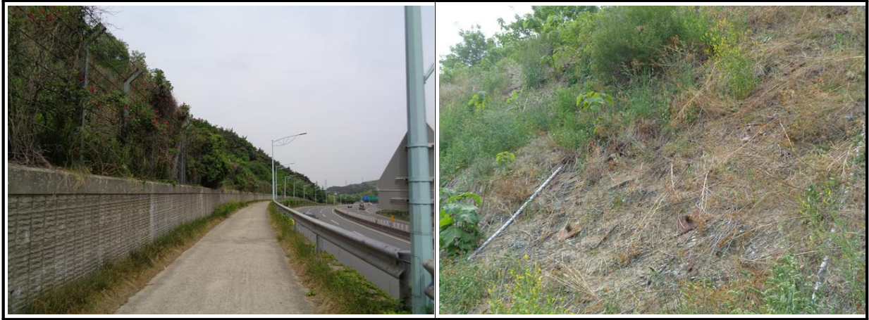
【그림 1.3.4】보호/보강시설 전경
